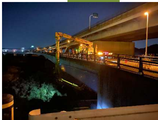
東部地区橋梁点検業務(国土交通省)
