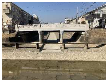
東住吉橋補修設計業務委託(京都市)
