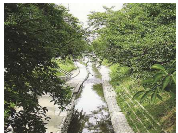
高田川環境整備/親水護岸(奈良県)
