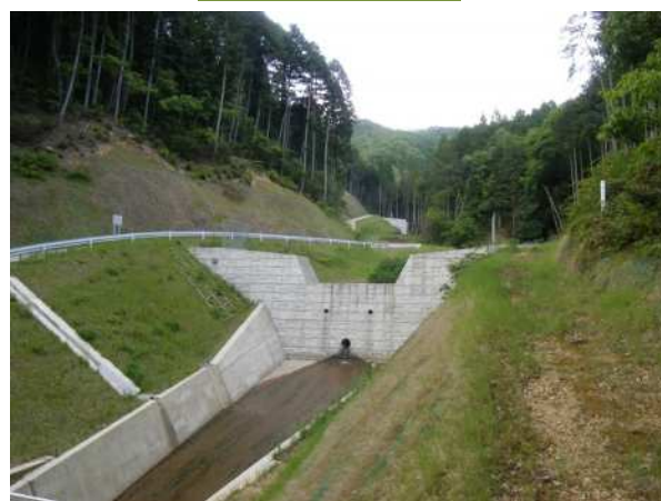
宮奥谷川砂防堰堤(京都府)
