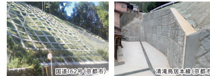
国道162号(京都市)
