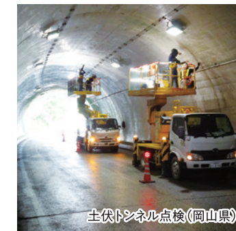
土伏トンネル点検(岡山県)
