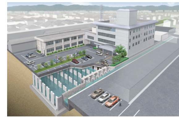
地下貯留施設設計図(奈良県)
