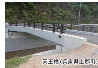
天王橋(兵庫県上郡町)
