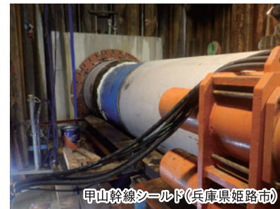
甲山幹線シールド(兵庫県姫路市)
