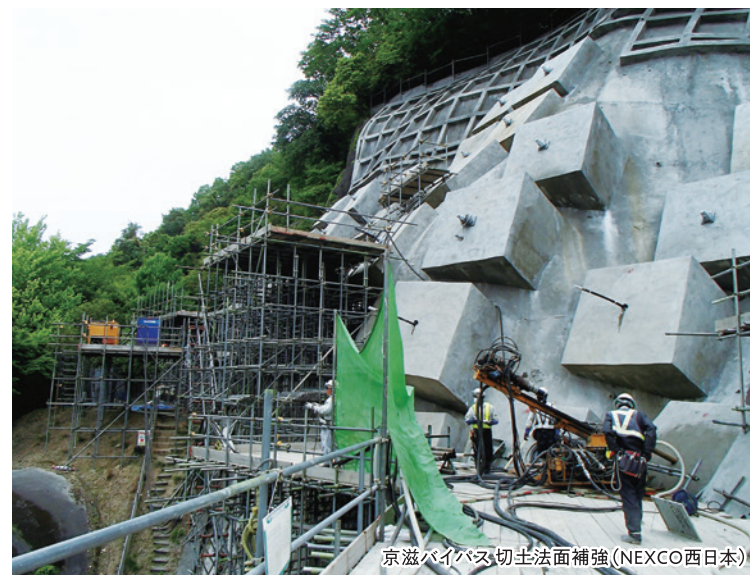
京都バイパス切土法面補強 (NEXCO西日本)
