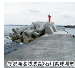
寺家漁港防波堤(石川県珠洲市)
