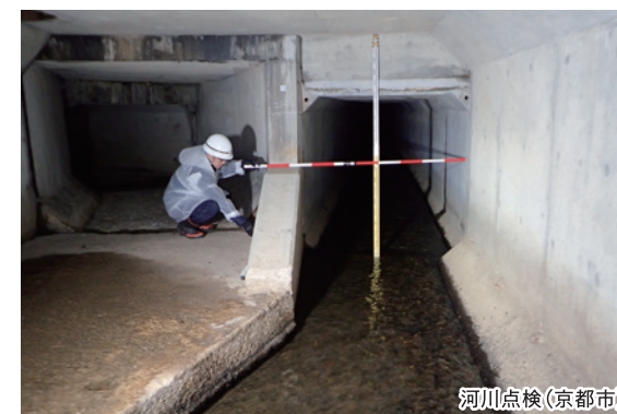
河川点検(京都市)
